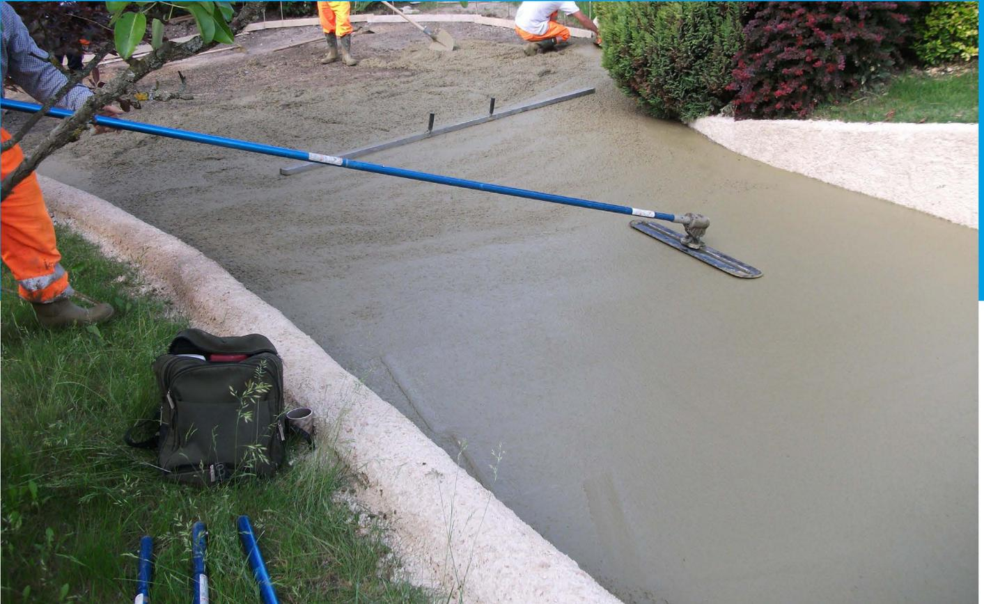
La dalle de béton d'une allée de garage doit pouvoir supporter la charge d'une voiture, et les fréquents passages de celle-ci. Nous vous conseillons par conséquent de vous préparer à réaliser une dalle de béton d'une épaisseur de 10 à 15 cm. Une fois prise, elle présente une solution sobre et simple à la solidité et durabilité de votre ouvrage.
