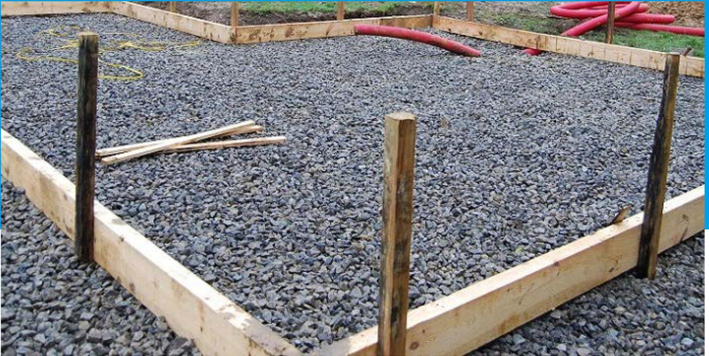
Réaliser une terrasse en extérieur n'est pas très compliqué mais demande de l'organisation et une bonne préparation du sol. En effet, avant de couler le béton, il convient de creuser le sol, d'installer un lit de gravats et de sable, et de mettre en place un coffrage.
